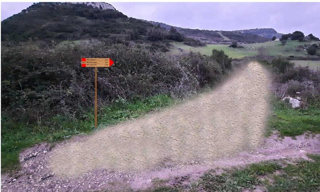
Funtana Santa Caterina situazione post intervento, ripristino sentiero e sistemazione segnaetica
