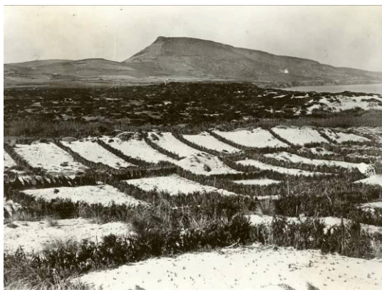
Foci del Coghinas (Castelsardo). Sistema di imbrigliamento delle sabbie litoranee con siepette morte basse.
