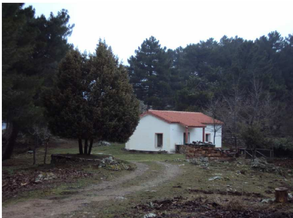
Figura 4.5 Struttura di servizio in localita Casa su Turighe (S.F. 79/2)
