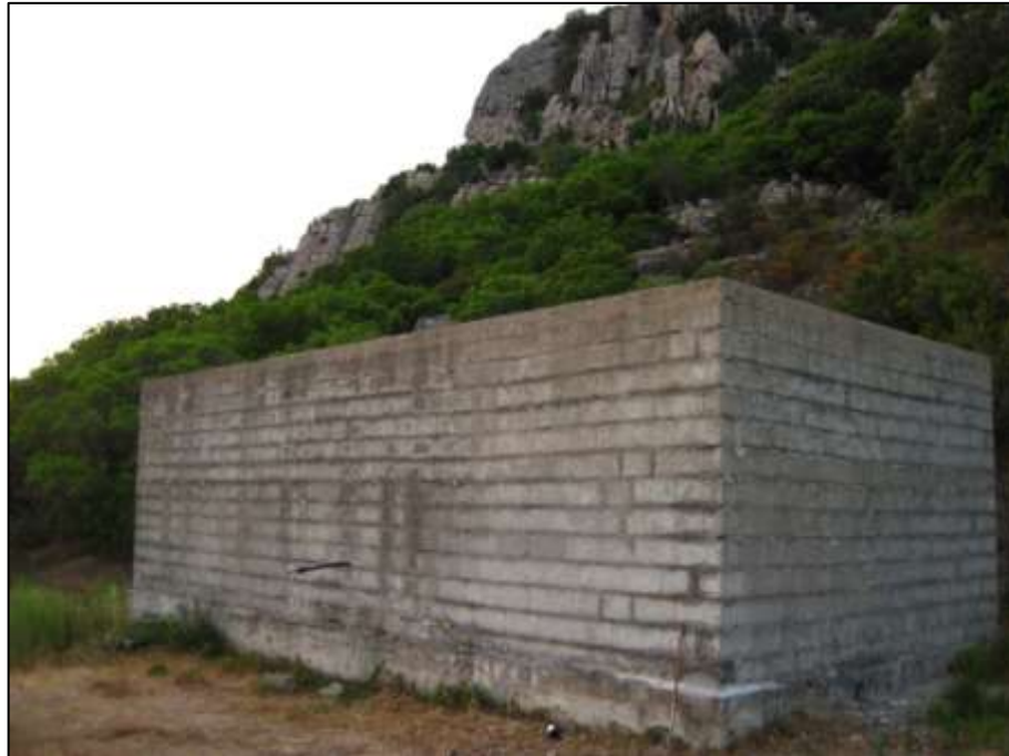
Figura 23: Deposito idrico nell'UGB Sorilis (SF 8_1)
